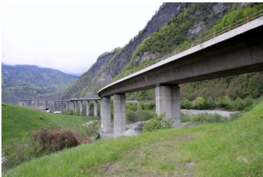
Le viaduc des Egratz sur la Route Blanche (RN205)
